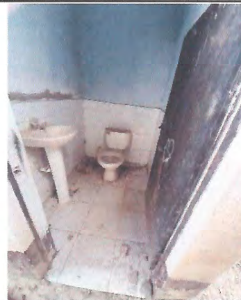
Foto 4: REPARACIÓN, MANTENIMIENTO Y MEJORAMIENTO DE SERVICIOS SANITARIOS.
